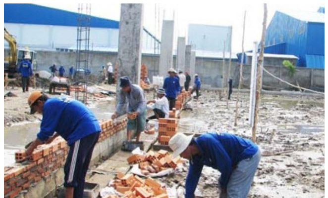
Hình 5a: Công trường xây dựng
